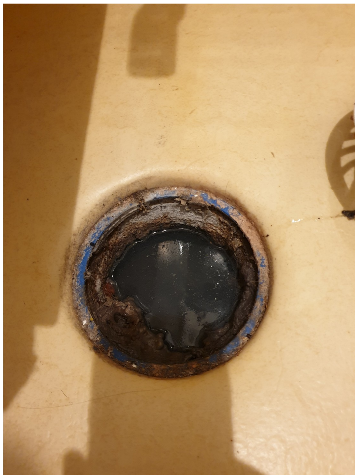
Golvbrunn i original i extra duschrum, av gjutjärn
